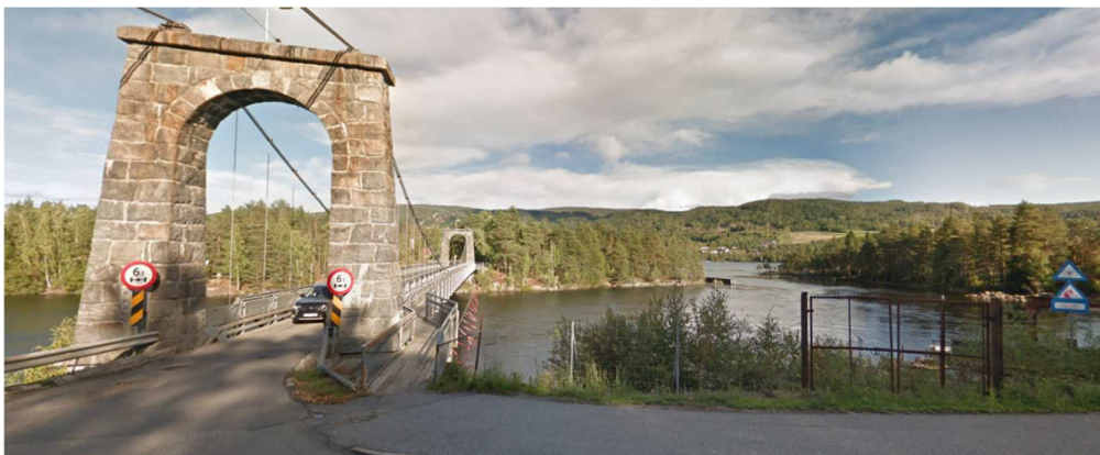
Bildet viser eksisterende hengebru, med utenforliggende fortau. Når ny bru er etablert vil eksisterende bru bli gang og sykkelveg.
