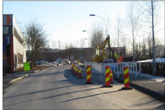
Riktig utført sikring og varsling.
