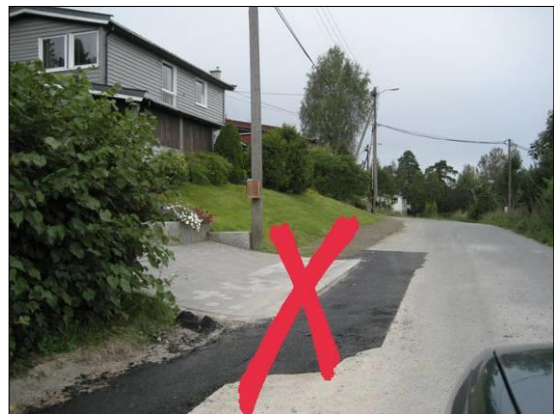
Uønsket endring av grøftetrasé.
