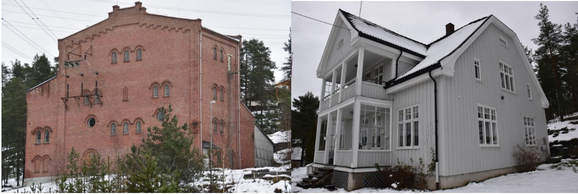
Gravfoss transformatorstasjon, bygd 1905-10. Maskinmesterboligen er bygd ca. 1910.
