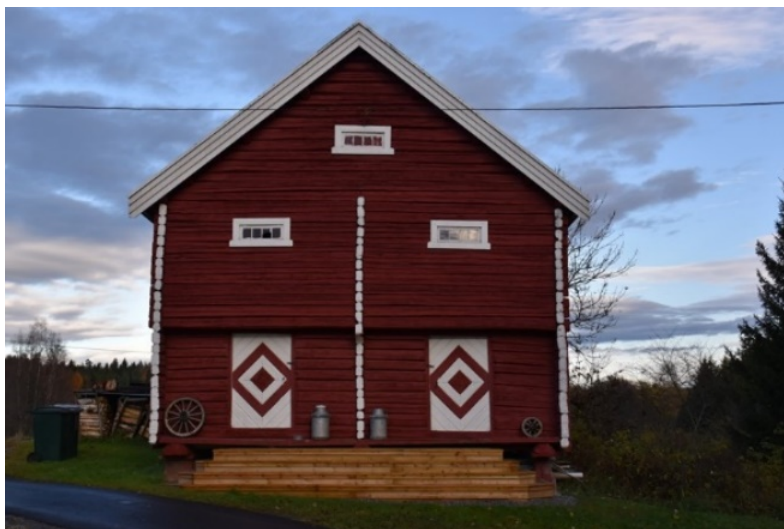
Stabburet på Gustad ved Stalsberg t.v. skal være bygd rundt 1650. Loftsetasjen krager en stokkebredd ut, men ellers er det typisk for den mest vanlige stabburstypen i Modum. Stabburet t.h. står på Skretteberg på Sysle. Det skal være fra 1745, men ble flyttet til dette tunet cirka år 1890. Trolig fikk det da sveitserstilpreget det har i dag. Det er nylig restaurert, med klokketårn og ny «gammel» krum tegl på taket.
