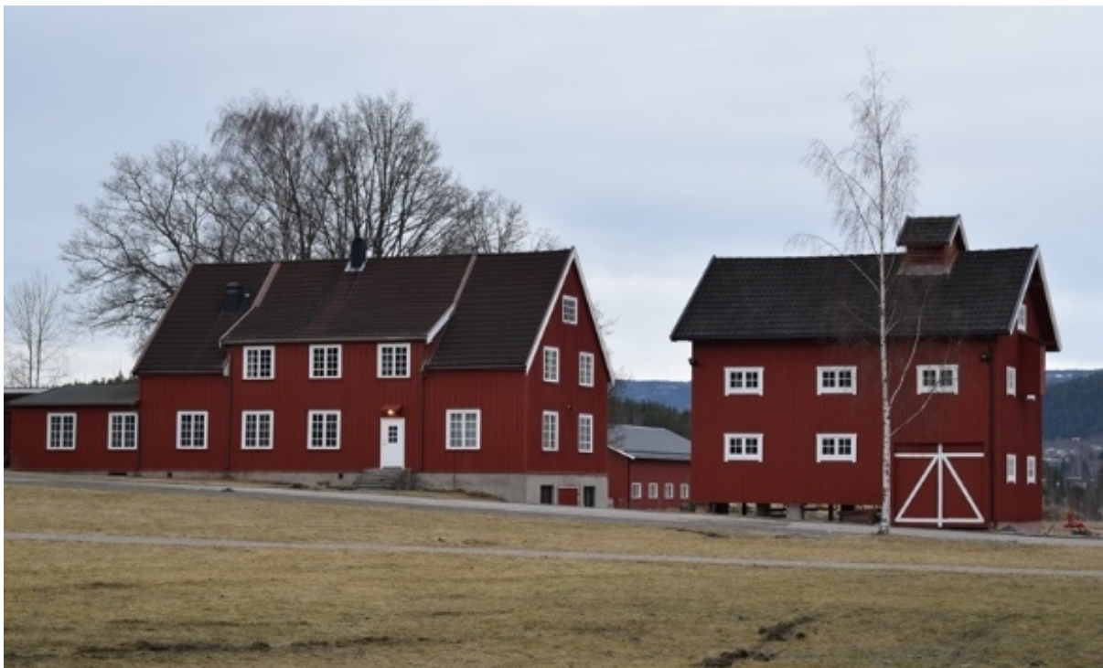
Snekkerverkstedet og magasinet er fra 1911, og er del av det eldste miljøet fra landbruksskolens oppstart. Bygningene er svært autentiske. Begge er i bindingsverk kledd med lektepanel, og vinduer med småruter.
