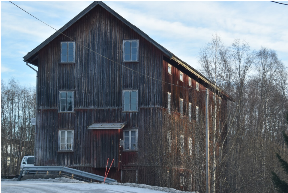
Bygningen ligger inntil Syslebekken.
