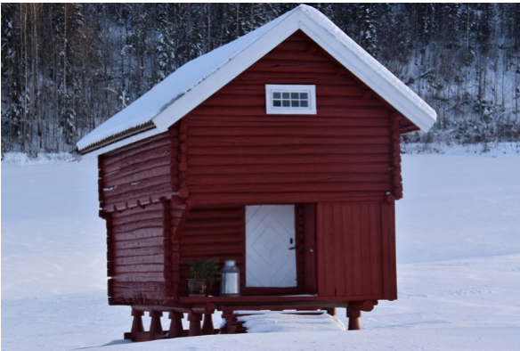
Stabburet på Gustad ved Stalsberg t.v. skal være bygd rundt 1650. Loftsetasjen krager en stokkebredd ut, men ellers er det typisk for den mest vanlige stabburstypen i Modum. Stabburet t.h. står på Skretteberg på Sysle. Det skal være fra 1745, men ble flyttet til dette tunet cirka år 1890. Trolig fikk det da sveitserstilpreget det har i dag. Det er nylig restaurert, med klokketårn og ny «gammel» krum tegl på taket.
