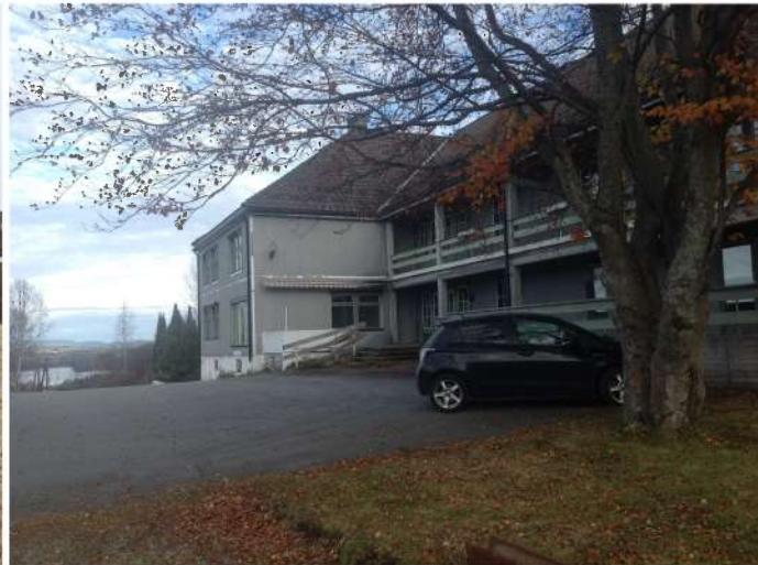
Eksisterende bygg, vestside
