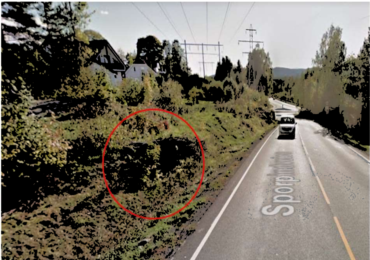
Figur 11: Berg i dagen nord-vest i og ved planområdet langs Sporpindveien
