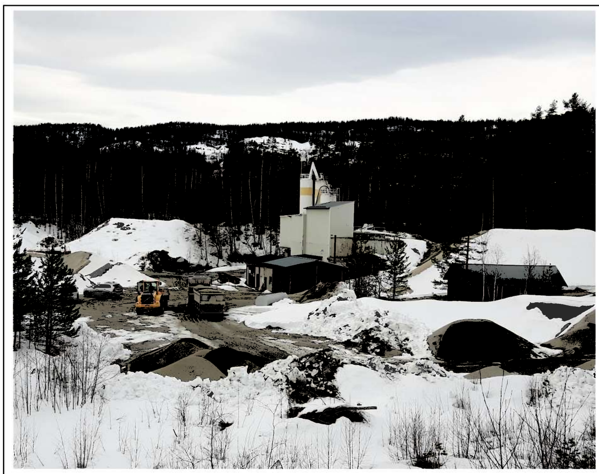
Bøen grustak med betongblandeverket til Unicon a/s, retning fra øst mot vest. Mars 2019.
