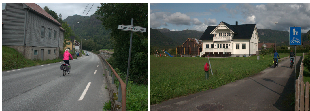
Figur V 13: Ulike sykkeløsninger i Sauda. Til venstre: Sykling i kjørebanelen på fv. 713 i retning Espeland. Til høyre: Separat gang- og sykkelvei.
