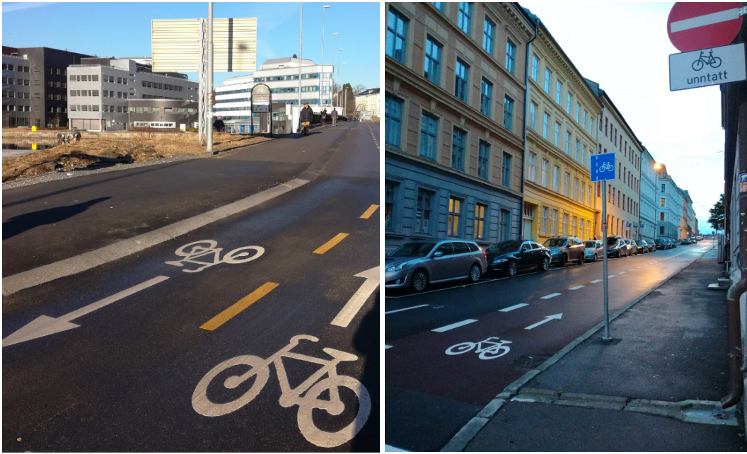
Figur 7: Eksempler på sykkelinfrastruktur. Fra venstre til høyre: Sykkelvei med fortau i Bergen. Rødt sykkelfelt mot enveiskjøring i Oslo. Foto: Oddrun Helen Hagen
