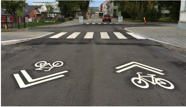
Figur 29: Eksempel på 'sharrows' fra pilotprosjekt i Levanger. Foto: Øyvind Henriksen 49
